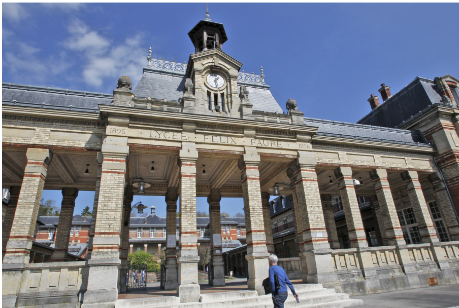
Galerie d'entrée du lycée Félix-Faure © JF. Bouché – Dir. de la communication, Ville de Beauvais
