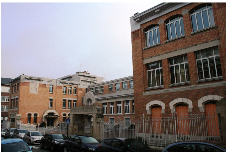
Le Conservatoire à Rayonnement Régional présente un bâtiment en briques ornementé d'éléments décoratifs faisant référence aux disciplines enseignées à l'instar de la musique et du théâtre © Claire Lefort
