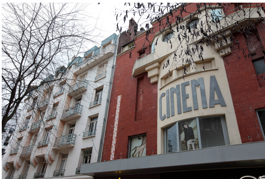
Façade de l'ancien cinéma Le Picardy, rue Ernest Cauvin © Laurent Rousselin
